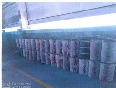
*Se realiza limpieza interna del colector de polvo y del banco de filtros que lo componen.*
